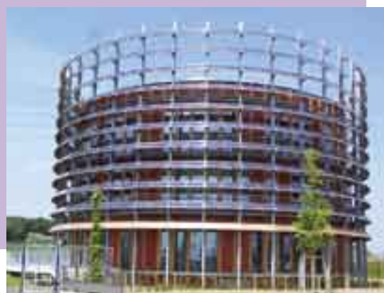
Exemple d'utilisation de panneaux photovoltaïques comme brise soleil
