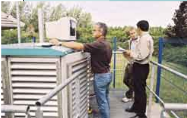
Pile à combustible au poste central trafic de la Communauté urbaine de Dunkerque (source Gaz de France)
